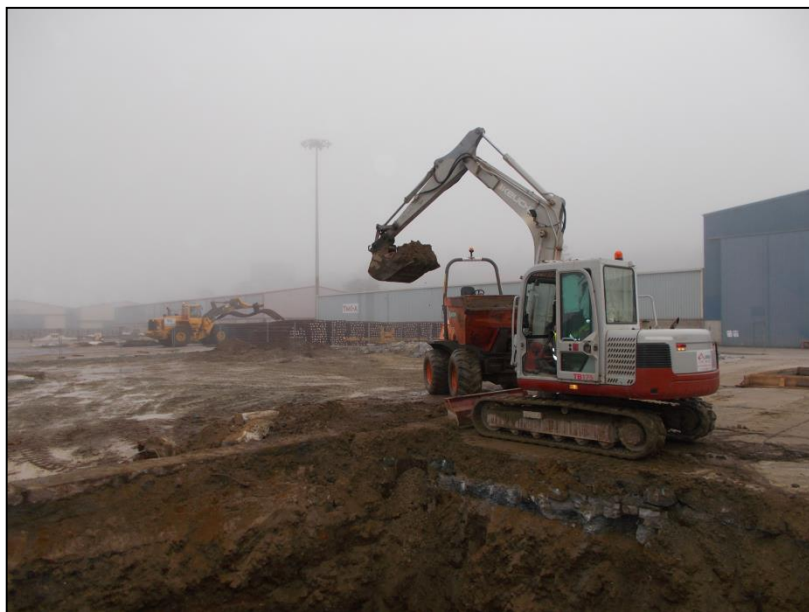
Excavación de zanjas e instalación de depósito
