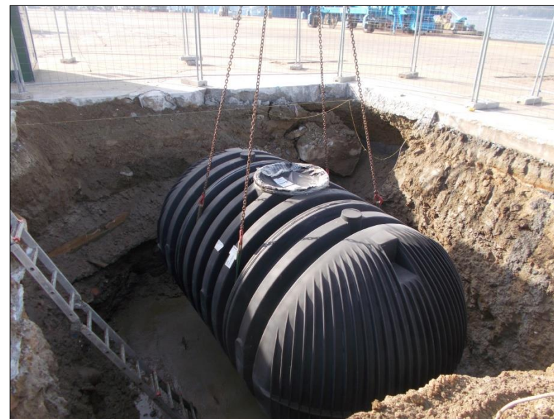
Excavación de zanjas e instalación de depósito
